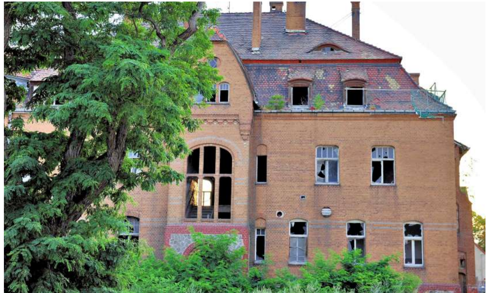
Das ehemalige Gutshaus in Gütz soll saniert werden.
