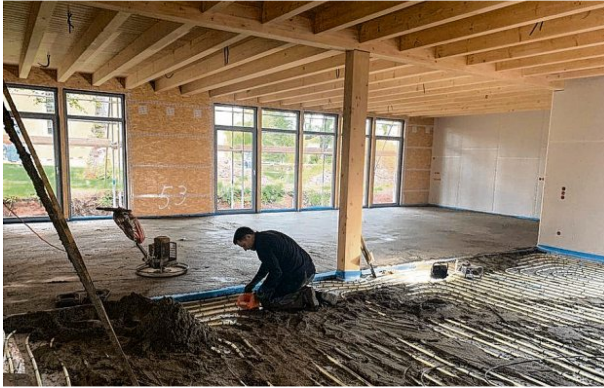
Auf Hochtouren sind die Arbeiten im Haus gelaufen.
