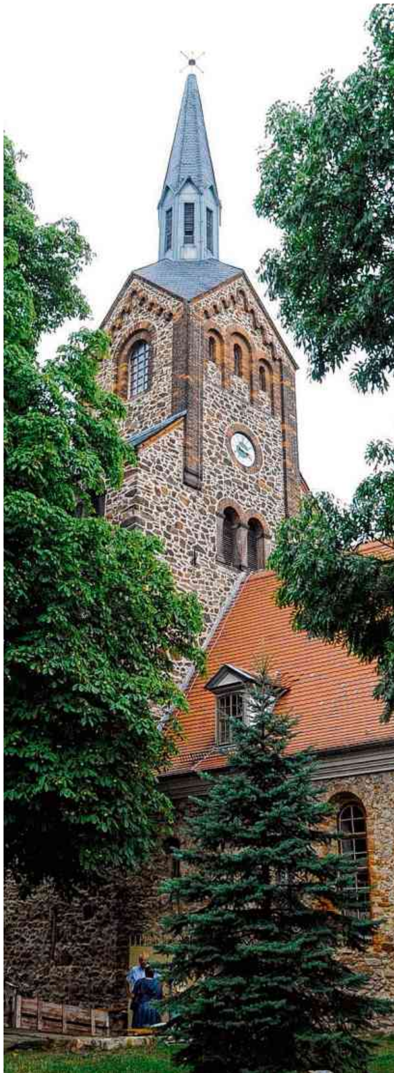
Die Sanierung ist abgeschlossen.
