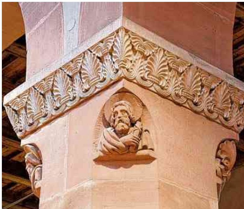
Die Ornamentik an den Sandsteinsäulen wurde restauriert.
