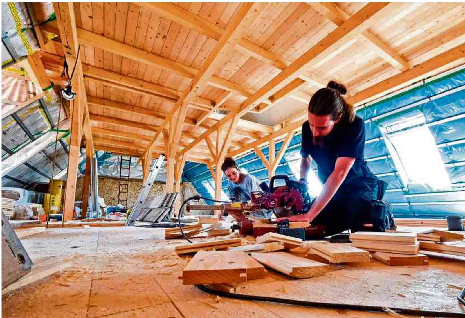
Undine Hannemann und Jan-Niklas Nichte bauen das Dachgeschoss der einstigen Scheune aus.
