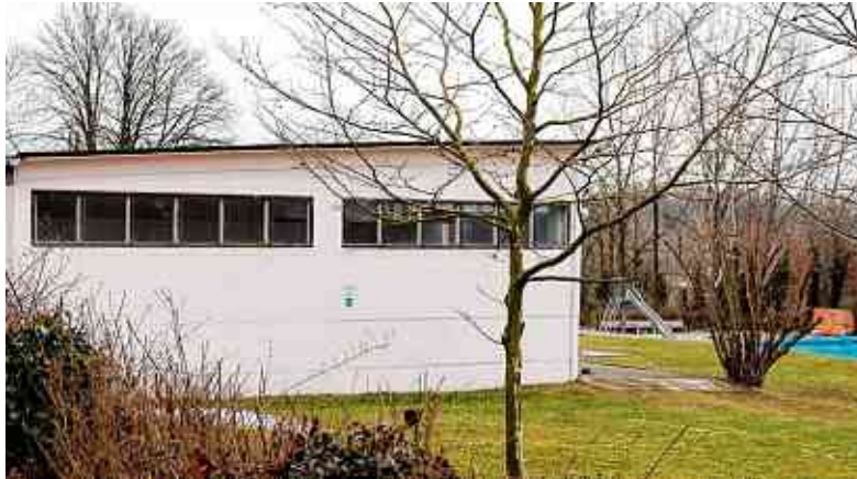
Fördermittel sind für die energetische Sanierung des Schwimmbadgebäudes beantragt worden.
