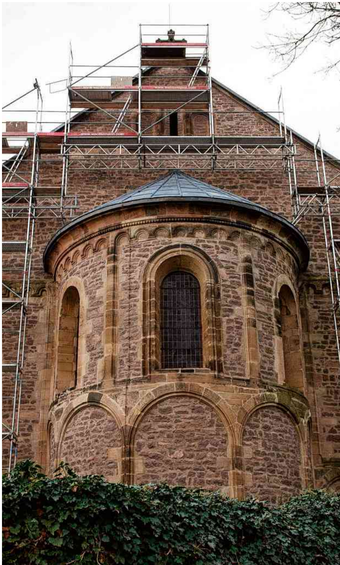
Die altherwürdige Klosterkirche ist seit langem eine Baustelle - und sie wird es noch eine Weile bleiben. Mehrere Gebäudeteile sind bereits saniert worden
